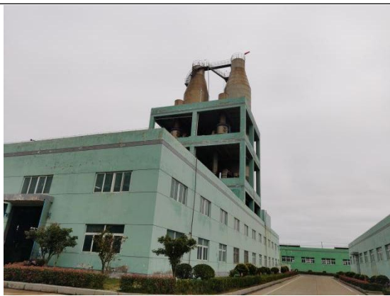
喷塔车间除尘器
