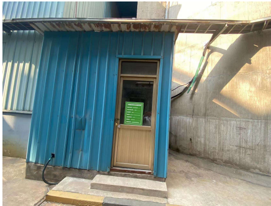
废气在线监测站
