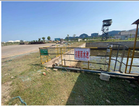
初期雨水收集池
