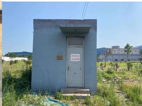
雨水排放口在线监测室
