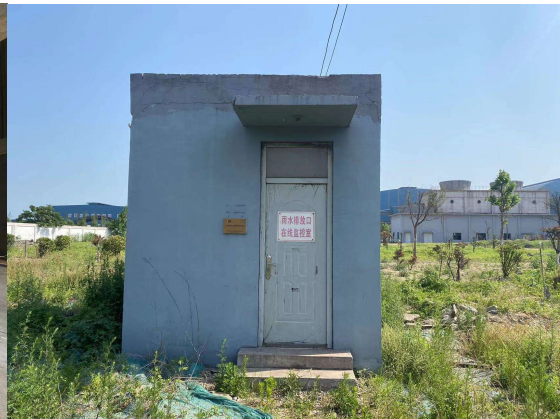
雨水排放口在线监测室
