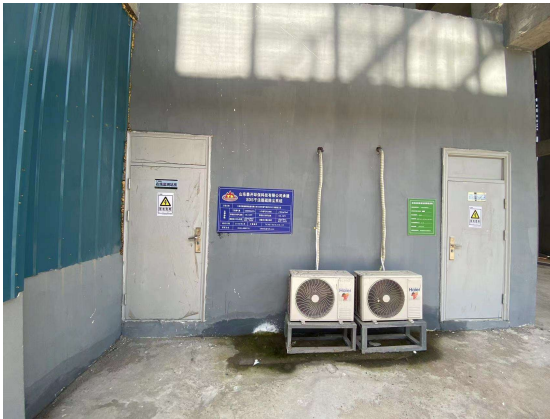
废气在线监测站
